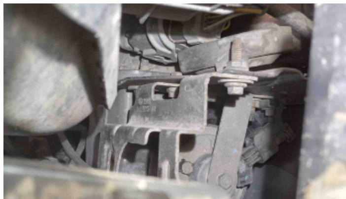
Foto Estrutura Longarina Esquerda
