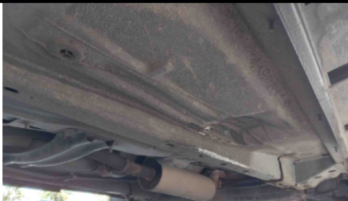
Foto Estrutura Assoalho
