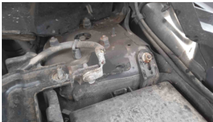
Foto Estrutura Torre do Amortecedor Esquerdo
