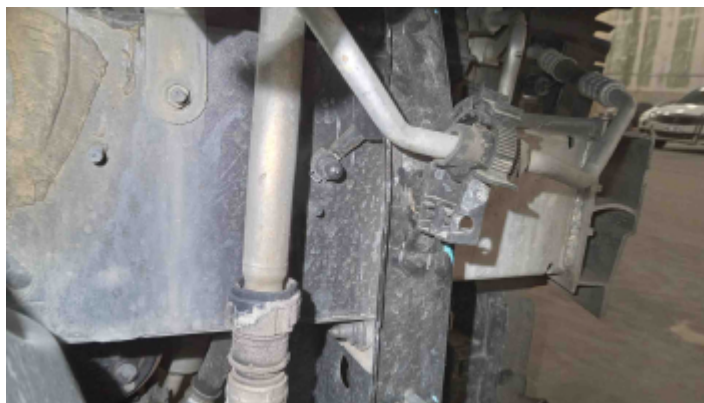
Foto Estrutura Longarina Direita
