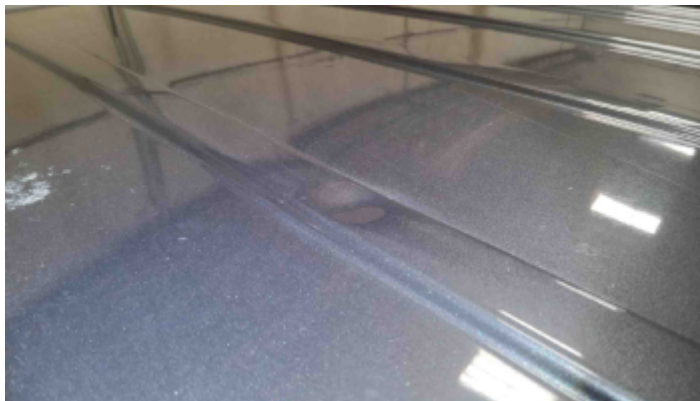
Foto Avaria Teto
