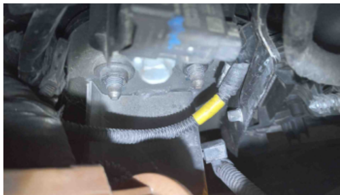
Foto Estrutura Longarina Esquerda
