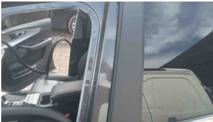
Foto Estrutura Coluna Central Esquerda
