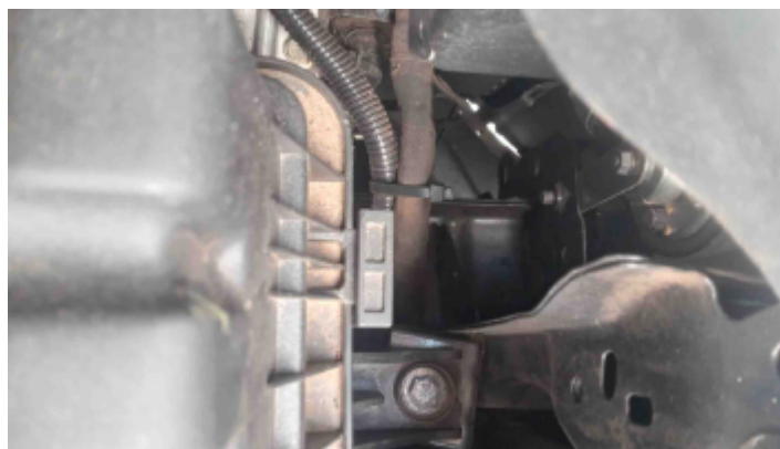
Foto Estrutura Longarina Esquerda
