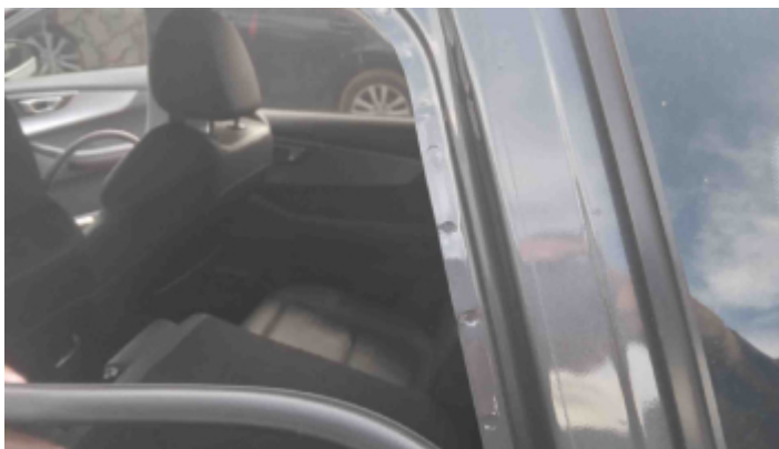
Foto Estrutura Coluna Traseira Esquerda
