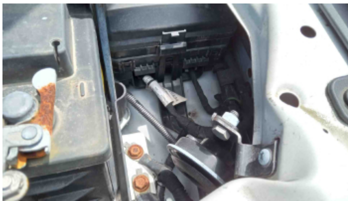
Foto Estrutura Torre do Amortecedor Esquerdo
