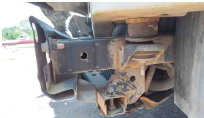
Foto Estrutura Longarina Esquerda
