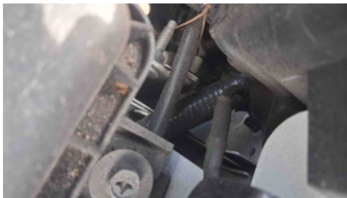
Foto Estrutura Longarina Esquerda
