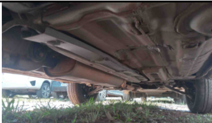
Foto Estrutura Assoalho
