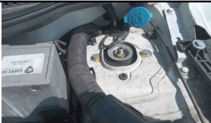
Foto Estrutura Torre do Amortecedor Esquerdo
