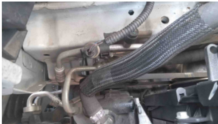
Foto Ar Condicionado
