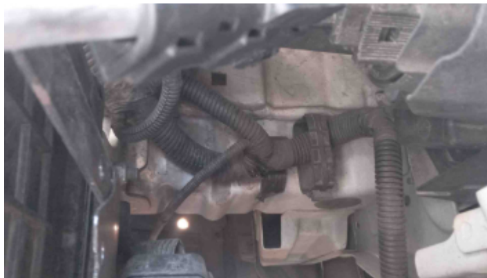
Foto Estrutura Longarina Esquerda
