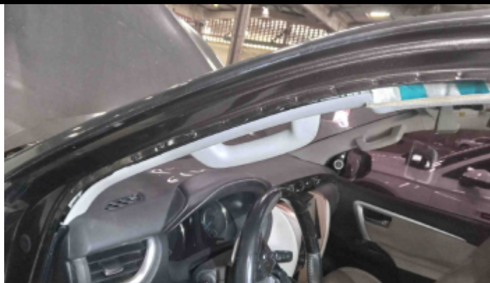
Foto Estrutura Coluna Dianteira Esquerda
