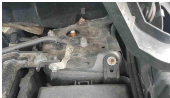
Foto Estrutura Torre do Amortecedor Esquerdo
