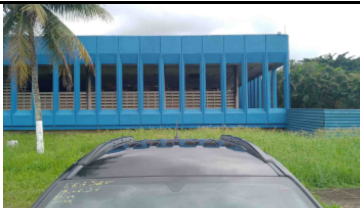
Foto Estrutura Teto
