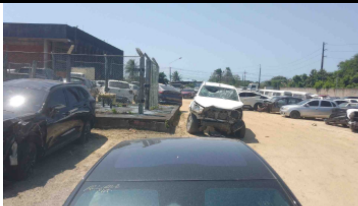
Foto Estrutura Teto
