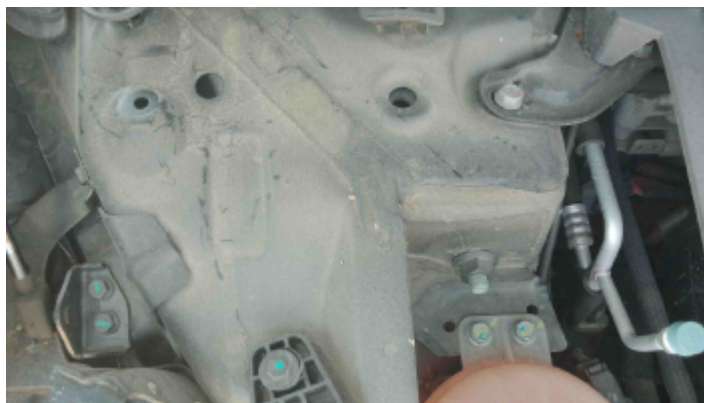
Foto Estrutura Torre do Amortecedor Direito
