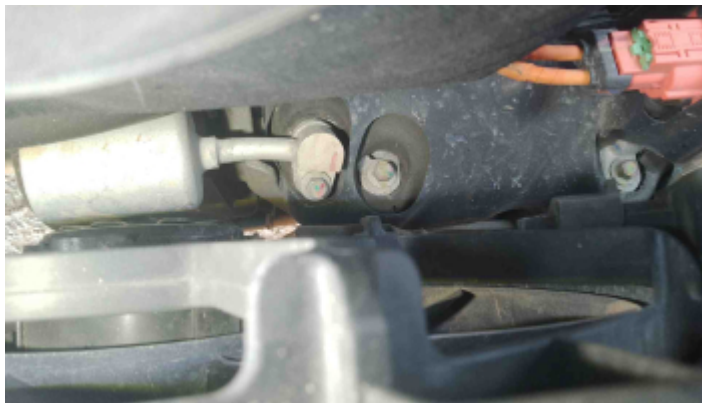
Foto Ar Condicionado
