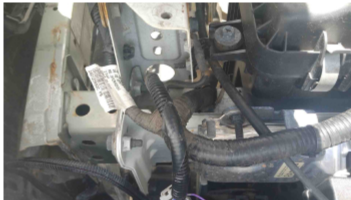
Foto Estrutura Longarina Esquerda
