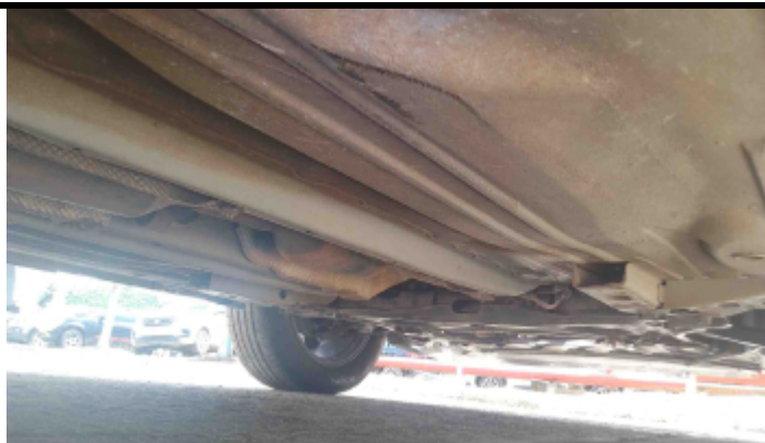
Foto Estrutura Assoalho
