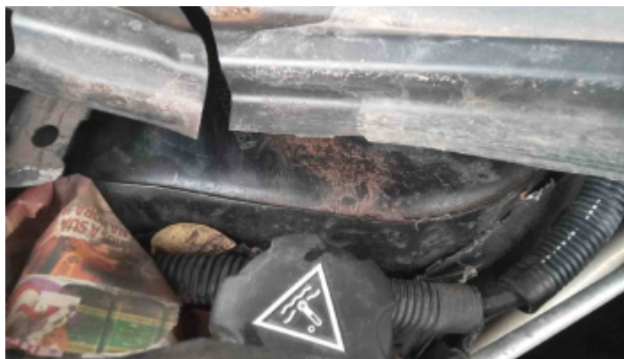
Foto Estrutura Torre do Amortecedor Direito
