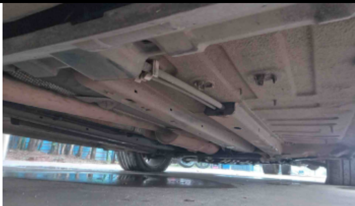
Foto Estrutura Assoalho
