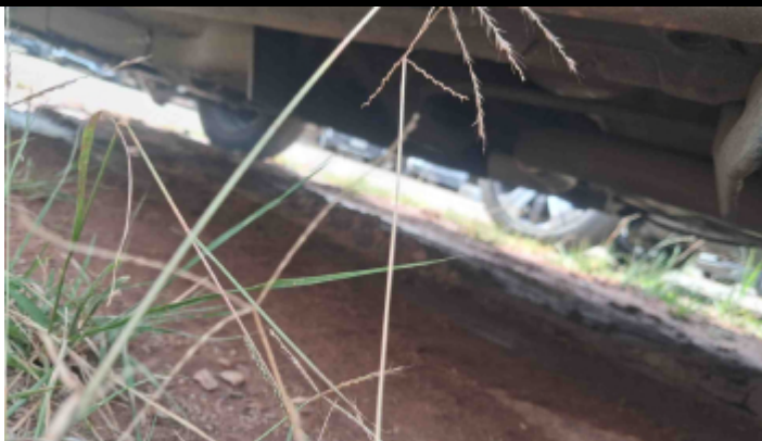
Foto Estrutura Assoalho
