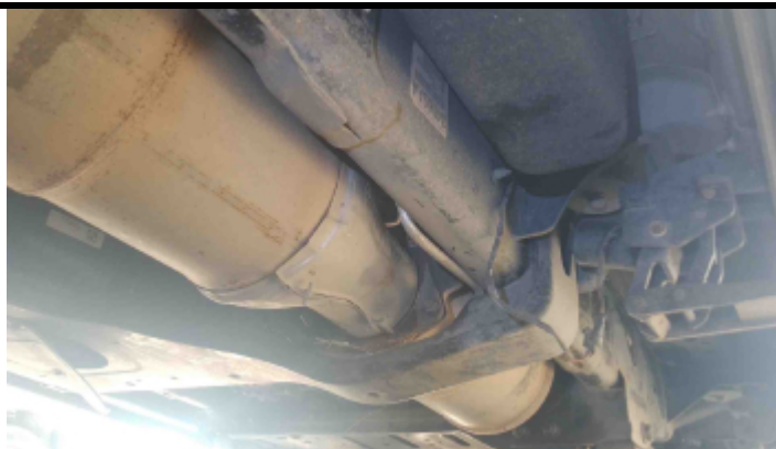
Foto Estrutura Assoalho
