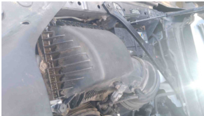
Foto Estrutura Torre do Amortecedor Direito
