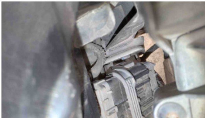
Foto Estrutura Longarina Esquerda
