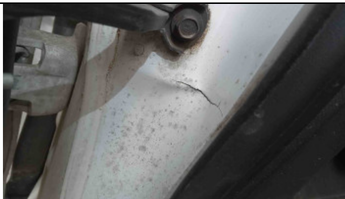
Detalhe da Avaria
