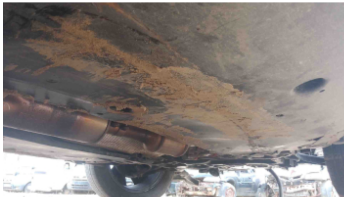
Foto Estrutura Assoalho
