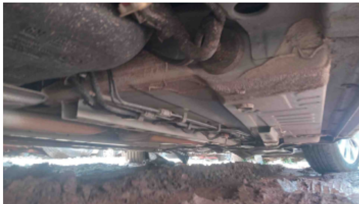
Foto Estrutura Assoalho
