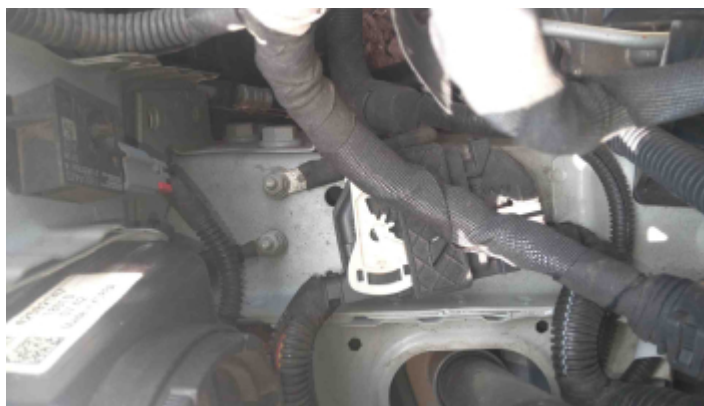
Foto Estrutura Longarina Esquerda
