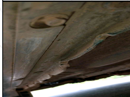
CAIXA DE AR/ SOLEIRA ESQUERDA
