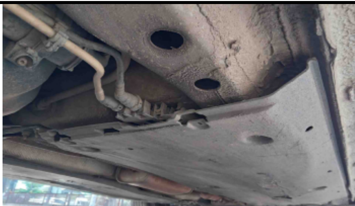
Foto Estrutura Assoalho
