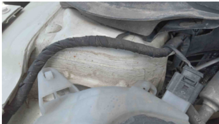
Foto Estrutura Torre do Amortecedor Direito
