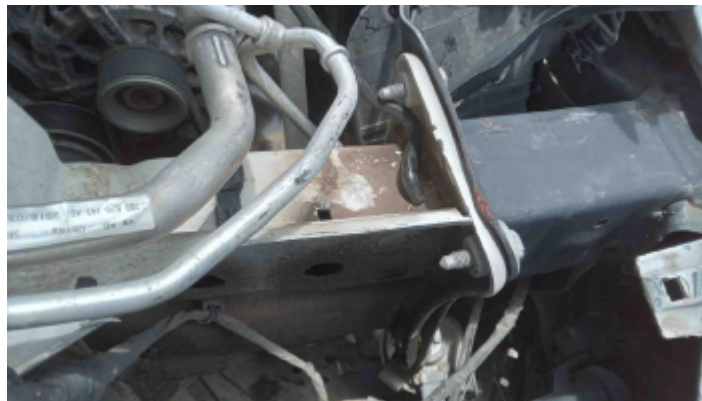
Foto Estrutura Longarina Direita
