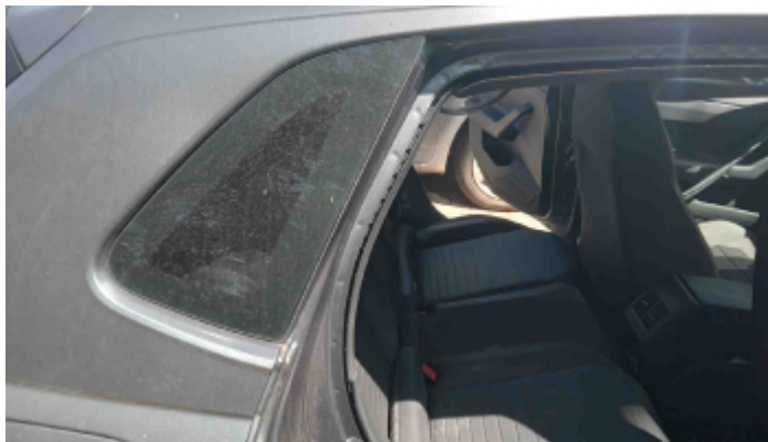
Foto Estrutura Coluna Traseira Direita
