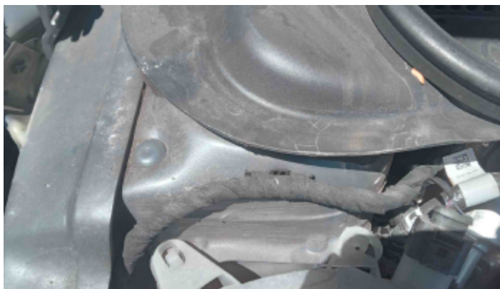
Foto Estrutura Torre do Amortecedor Direito
