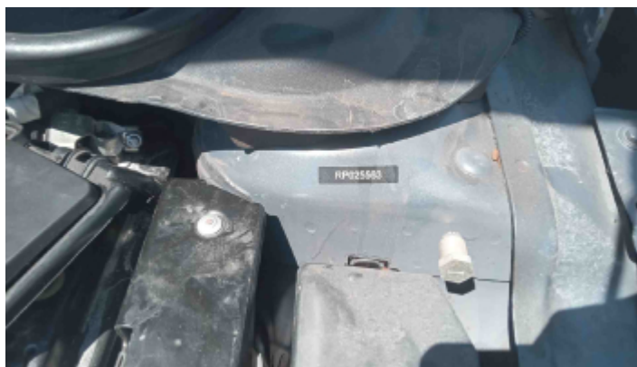
Foto Estrutura Torre do Amortecedor Esquerdo
