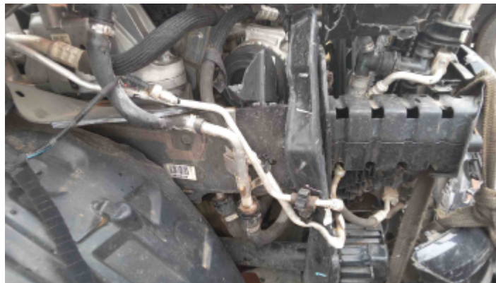
Foto Estrutura Longarina Direita
