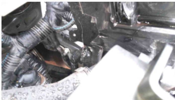
Foto Estrutura Longarina Esquerda
