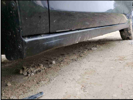
CAIXAS DE AR - SOLEIRA ESQUERDA
