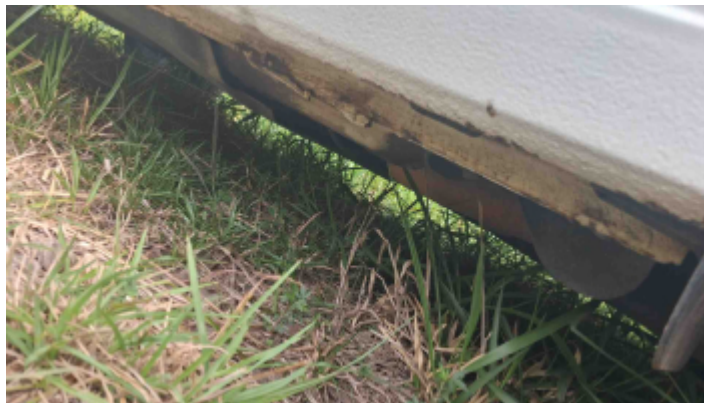
Foto Estrutura Assoalho
