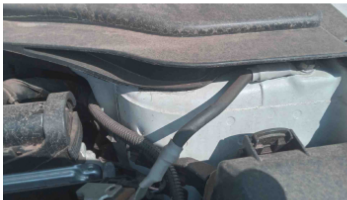
Foto Estrutura Torre do Amortecedor Esquerdo
