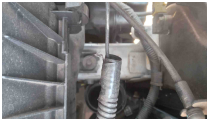
Foto Estrutura Longarina Esquerda
