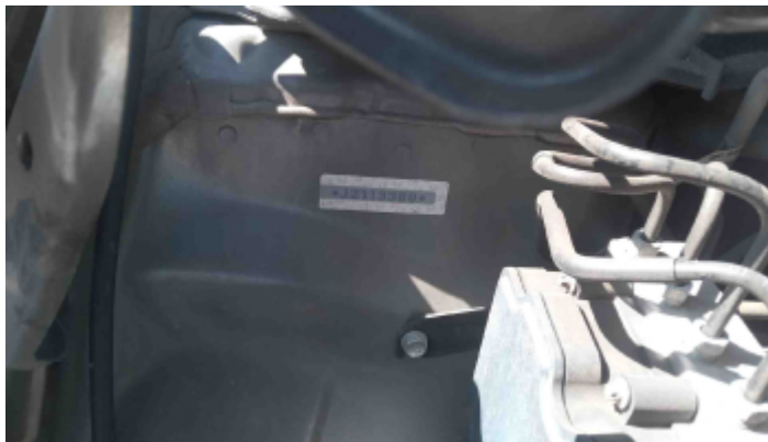
Foto Estrutura Torre do Amortecedor Direito
