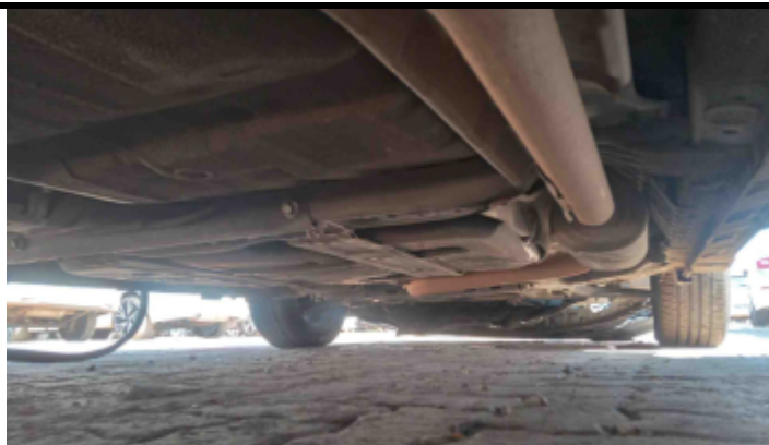
Foto Estrutura Assoalho
