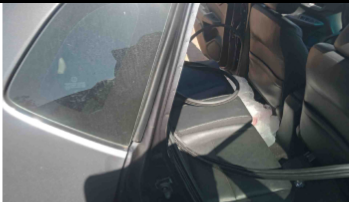
Foto Estrutura Coluna Traseira Direita
