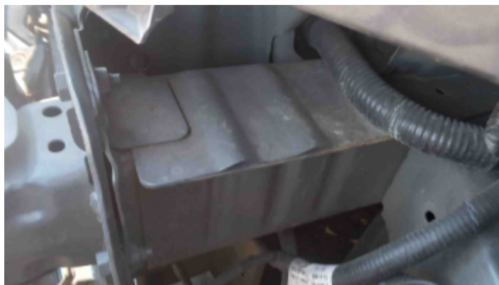
Foto Estrutura Longarina Esquerda
