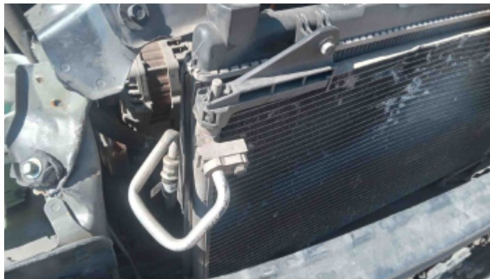
Foto Ar Condicionado
