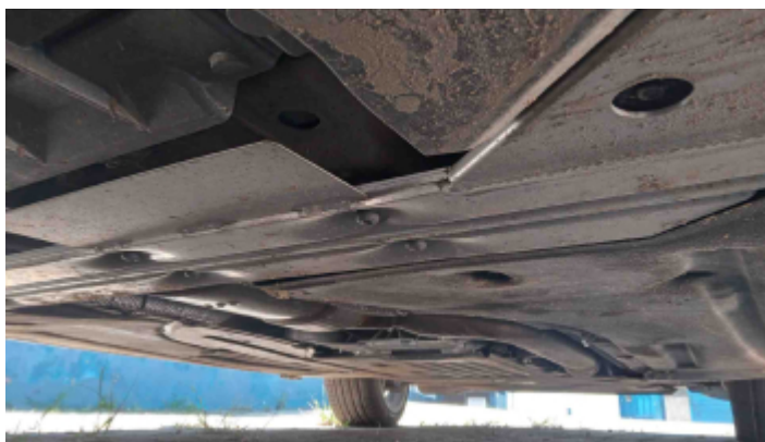
Foto Estrutura Assoalho
