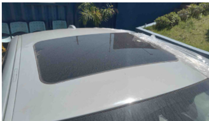
Foto Estrutura Teto
