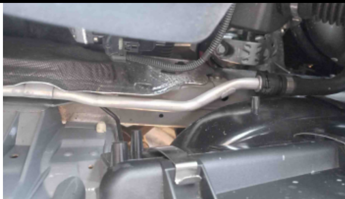
Foto Estrutura Longarina Direita
