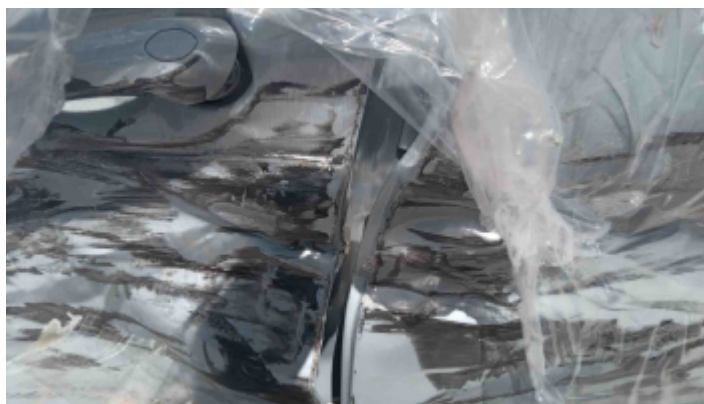
Foto Estrutura Coluna Central Esquerda
