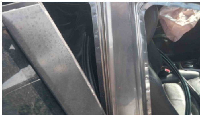
Foto Estrutura Coluna Central Direita
