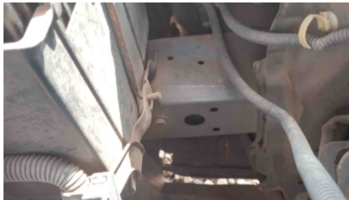
Foto Estrutura Longarina Esquerda
