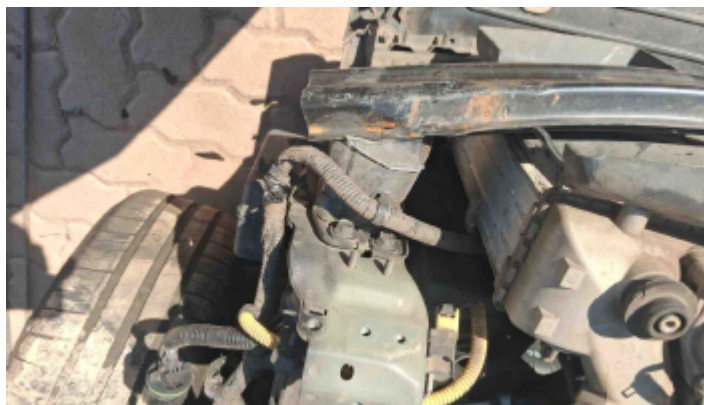
Foto Estrutura Longarina Esquerda
