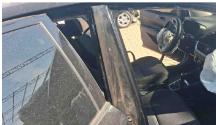
Foto Estrutura Coluna Central Direita
