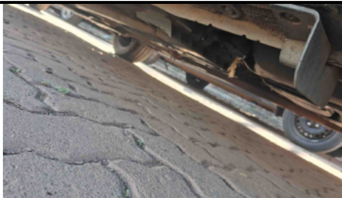
Foto Estrutura Assoalho
