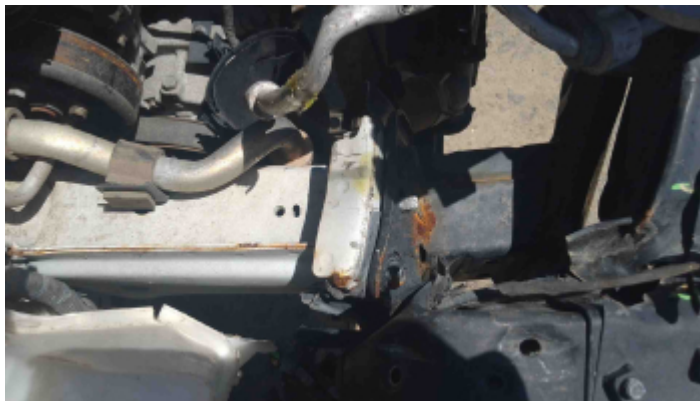
Foto Estrutura Longarina Direita
