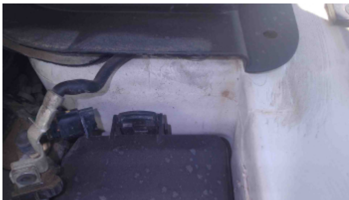
Foto Estrutura Torre do Amortecedor Esquerdo
