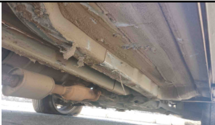
Foto Estrutura Assoalho
