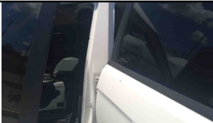
Foto Estrutura Coluna Central Esquerda
