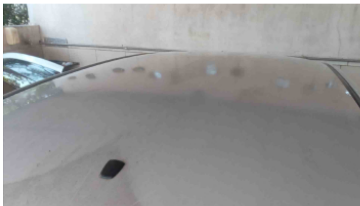
Foto Estrutura Teto
