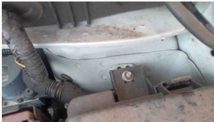
Foto Estrutura Torre do Amortecedor Esquerdo
