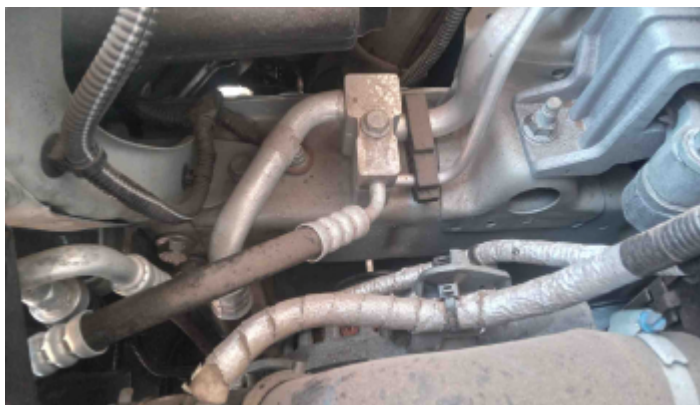
Foto Ar Condicionado
