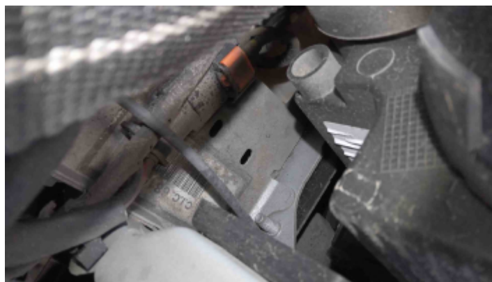
Foto Estrutura Longarina Esquerda
