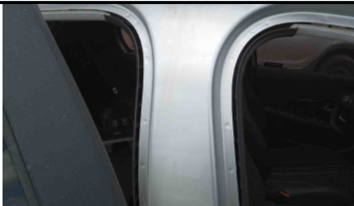
Foto Estrutura Coluna Central Direita
