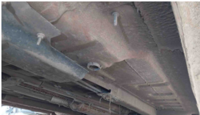
Foto Estrutura Assoalho
