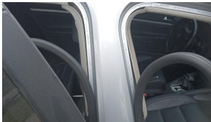
Estrutura Coluna Central Direita
