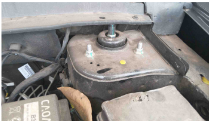
Foto Estrutura Torre do Amortecedor Esquerdo
