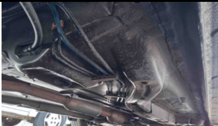
Foto Estrutura Assoalho
