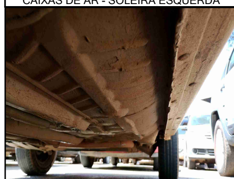
CAIXAS DE AR - SOLEIRA ESQUERDA
