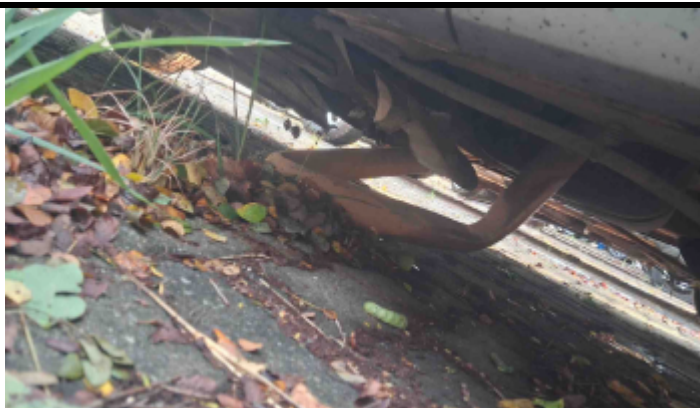
Foto Estrutura Assoalho
