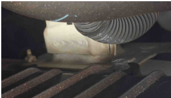
Foto Estrutura Longarina Esquerda
