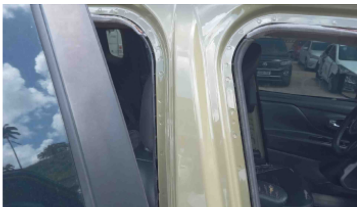
Foto Estrutura Coluna Central Direita
