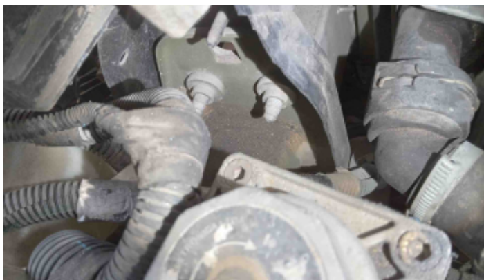
Foto Estrutura Longarina Esquerda
