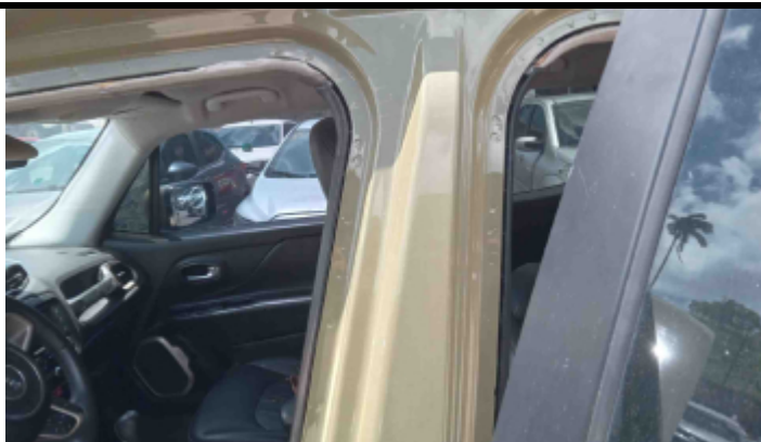
Foto Estrutura Coluna Central Esquerda
