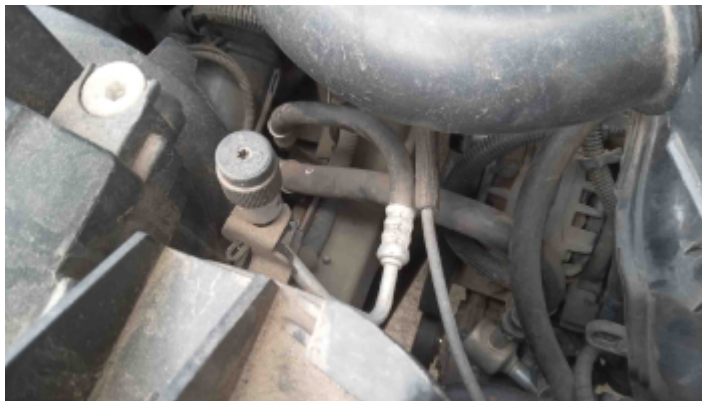
Foto Ar Condicionado
