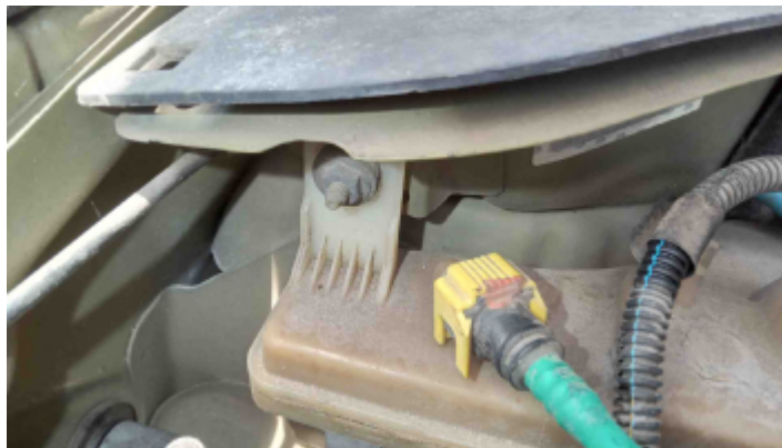
Foto Estrutura Torre do Amortecedor Direito
