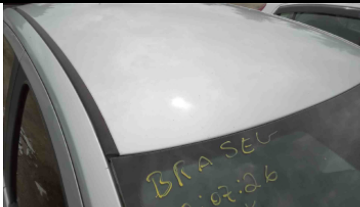
Foto Estrutura Teto
