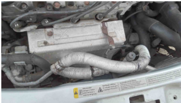
Foto Ar Condicionado
