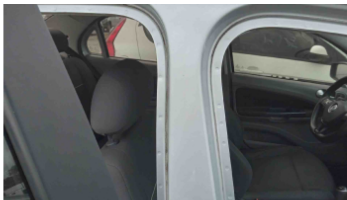
Foto Estrutura Coluna Central Direita
