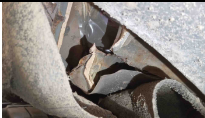
Detalhe da Avaria
