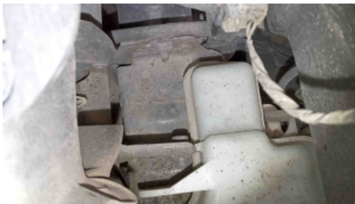
Foto Estrutura Longarina Direita
