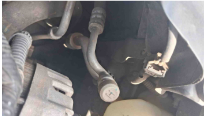
Foto Estrutura Longarina Direita
