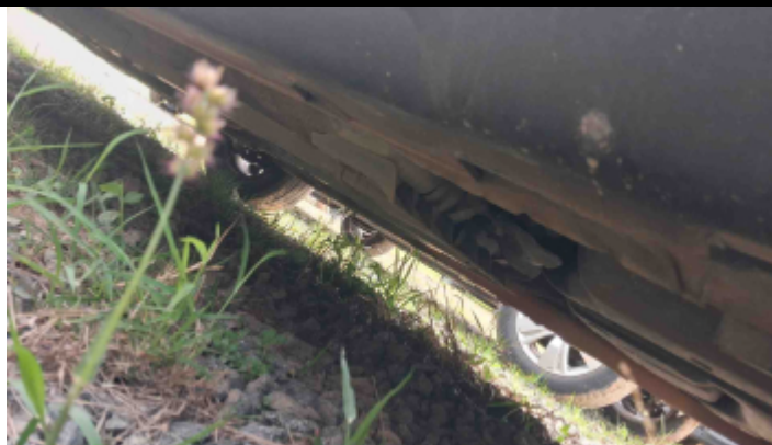
Foto Estrutura Assoalho
