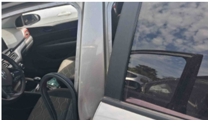
Foto Estrutura Coluna Central Esquerda
