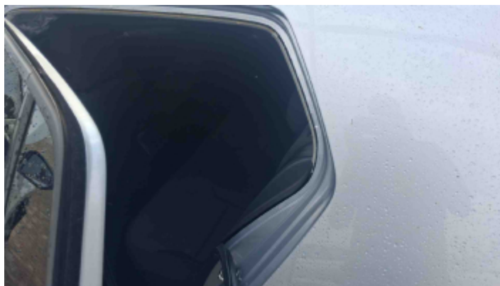
Foto Estrutura Coluna Traseira Esquerda
