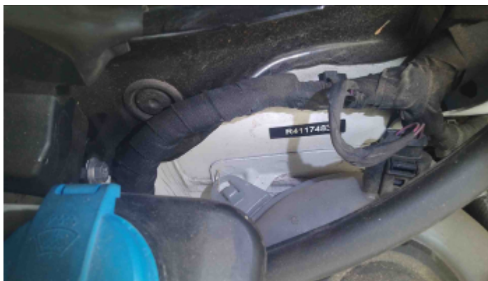
Foto Estrutura Torre do Amortecedor Direito
