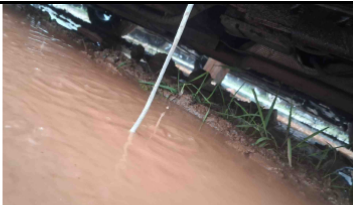
Foto Estrutura Assoalho
