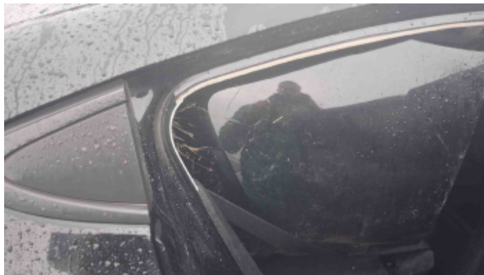
Foto Estrutura Coluna Traseira Direita
