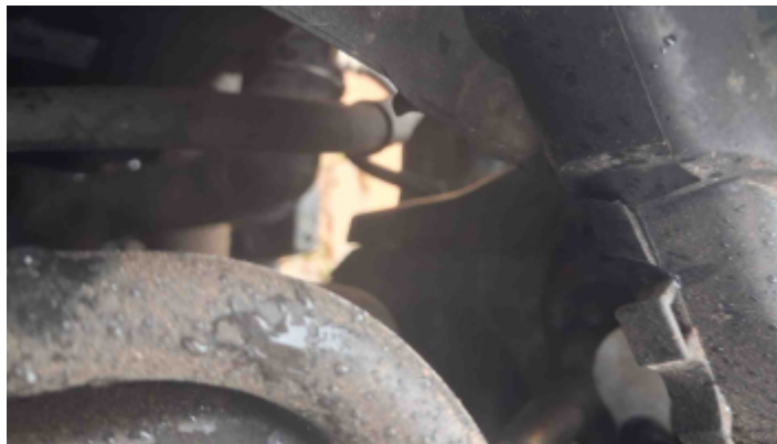
Foto Estrutura Longarina Direita
