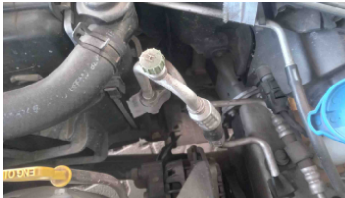
Foto Ar Condicionado
