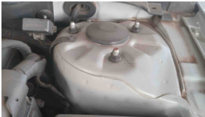
Foto Estrutura Torre do Amortecedor Esquerdo
