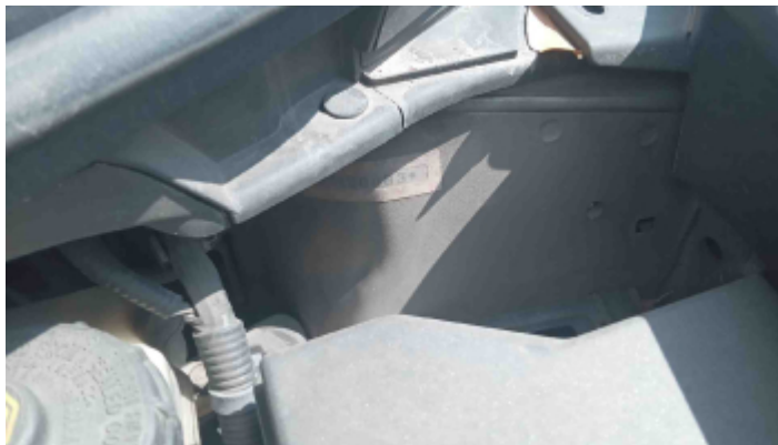
Foto Estrutura Torre do Amortecedor Esquerdo
