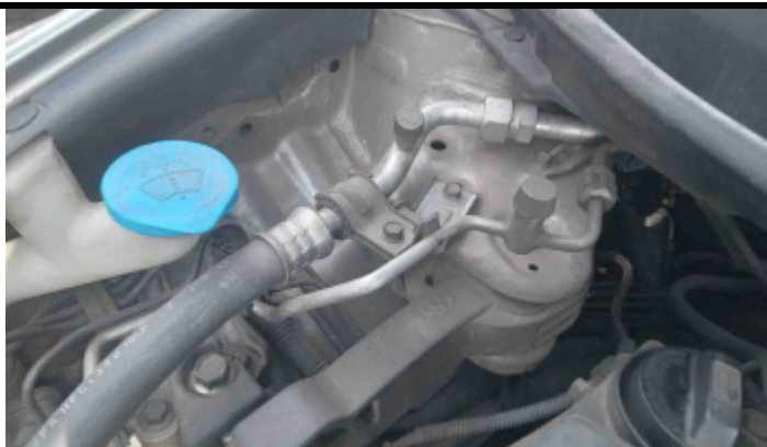
Foto Ar Condicionado
