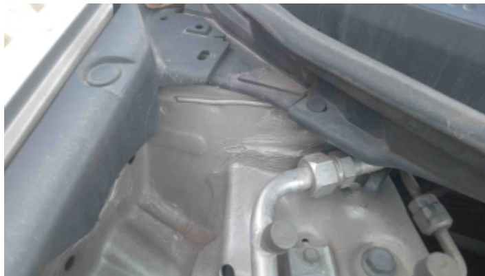
Foto Estrutura Torre do Amortecedor Direito
