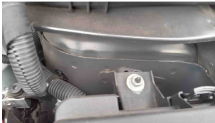
Foto Estrutura Torre do Amortecedor Esquerdo
