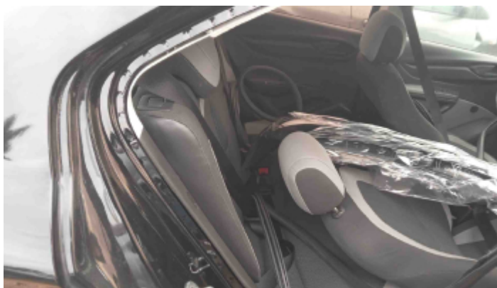
Foto Estrutura Coluna Traseira Direita
