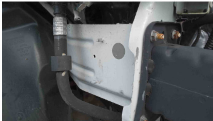
Detalhe da Avaria
