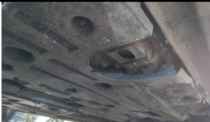
Foto Estrutura Assoalho
