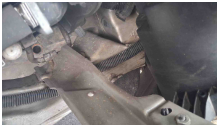
Foto Estrutura Longarina Esquerda
