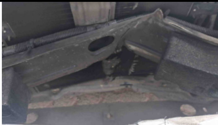
Foto Avaria Painel/Saia Dianteiro
