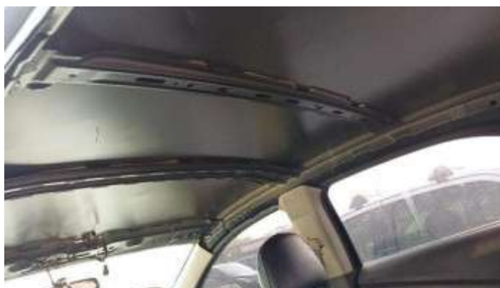
Revestimento do teto
