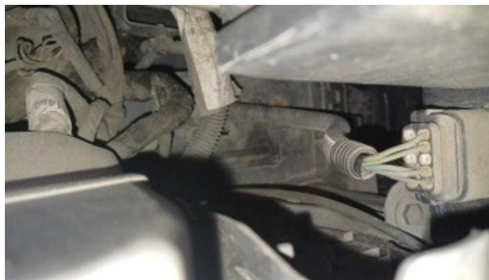
Estrutura Longarina Esquerda
