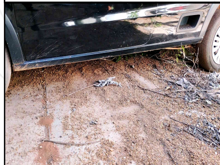
CAIXA DE AR/ SOLEIRA ESQUERDA
